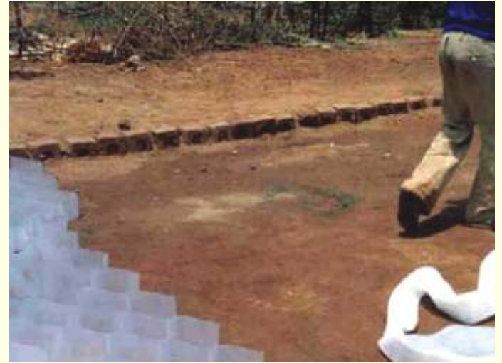
चित्र-2 प्लास्टिक के सेल्स की संरचना बिछाई जा रही है
