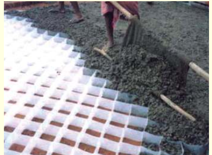
चित्र-3 कंक्रीट को प्लास्टिक सेल्स में डाला जा रहा है
