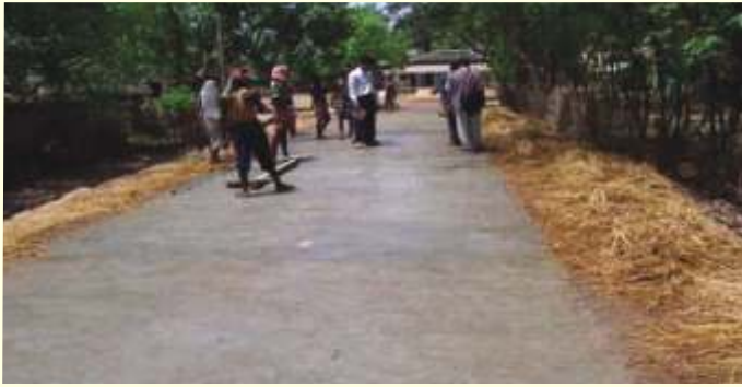
चित्र-5 सड़क के उपचार के लिए प्रयोग में लाए गए धान के गीले पुआल को हटाने के बाद कंकरीट सड़क की परिष्कृत सतह
