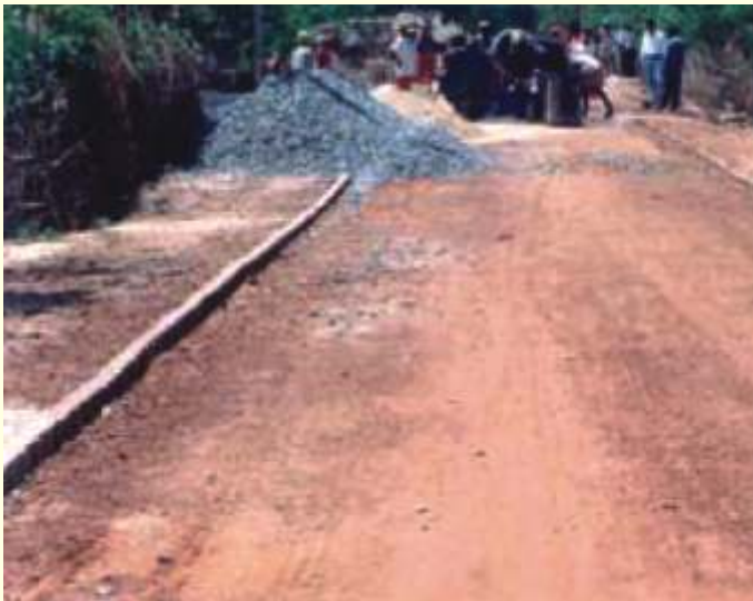
चित्र-1 पेवमेन्ट के किनारों के साथ अंतिम सिरे पर ईंटें लगे मर्रम की उप-तह
